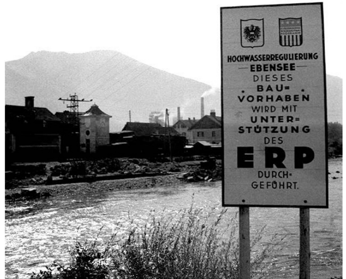
Hochwasserschutzbauten in Ebensee. Errichtung mittels ERP-Finanzierung
